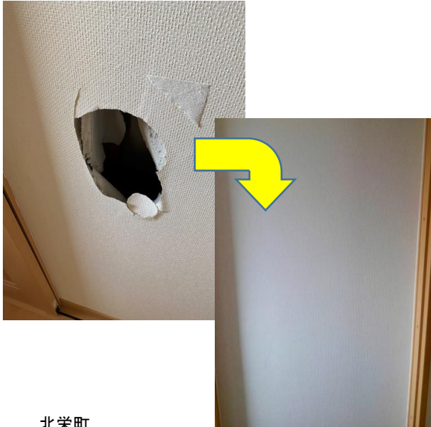
北栄町 穴の空いた壁も、クロスを貼り替えることで、この通り綺麗に 仕上げられます。
