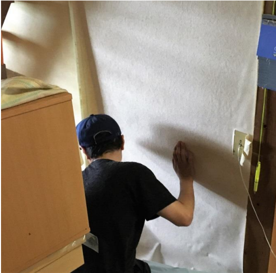
T邸廊下クロス張替え工事 古い壁紙を剥がして新しいクロスを張ります。 弊社、池原くんが施工中です。
